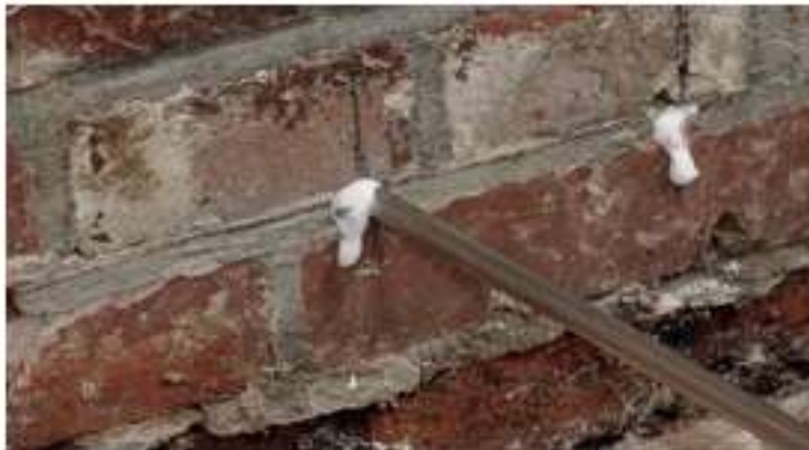
Abdichtung mit der Cremetechnologie
